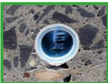
Nur **biegsame Rohre** garantieren einen ausreichenden Innendurchmesser für das Einziehen von Kabeln.
