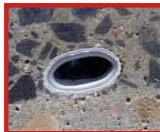
Bei biegsamen, **sich selbst zurückbildenden Rohren** besteht die Gefahr, dass das Einziehen von Kabeln unmöglich wird.
