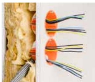
Hier wird eine diffusionshemmende Dampfbremse auf der warmen Seite der Dämmung eingebracht, die keine Undichtigkeiten aufweisen darf.
