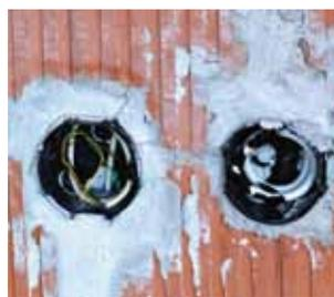
Hier stellt der Innenputz die Luftdichte Ebene zu Außenwänden bzw. Wohnungstrennwänden dar.
